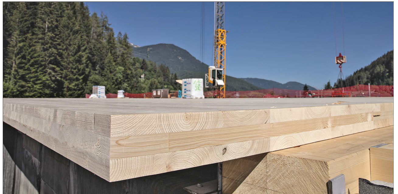
Drei-Schicht-CLT von Pfeifer im Querschnitt
